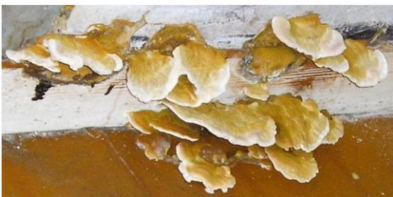
La mэрule peut également s'étendre horizontalement sous forme de plateaux consistants en dessous desquels s'échappent des millions de spores. Sur la photo, le plancher semble peint mais en réalité il est couvert de spores.
