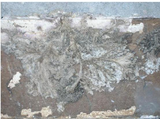
Les rizomorphes sont de véritables tuyaux de canalisation. L'eau récoltée est acheminée jusqu'aux zones les plus éloignées par ces filaments minuscules de l'ordre de 10 µm à 6 mm de diamètre.
